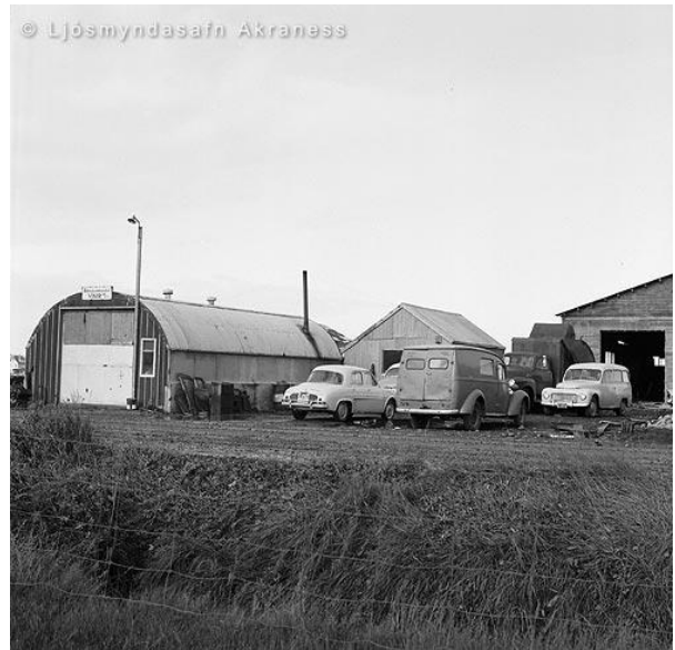
13. mynd Verkstæðishús við Þjóðbraut. Ljósmyndasafn Akraness, Ólafur Árnason.
